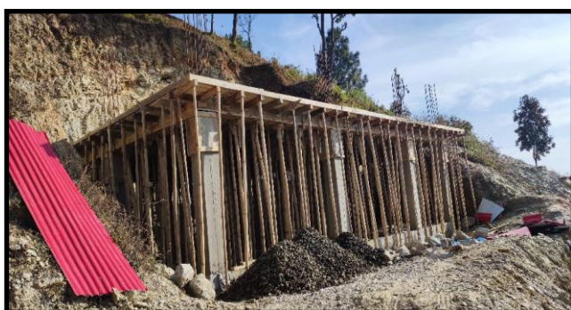
निर्माणाधीन लालिगुराँस आमा समूह भवन-थेचम्बु
